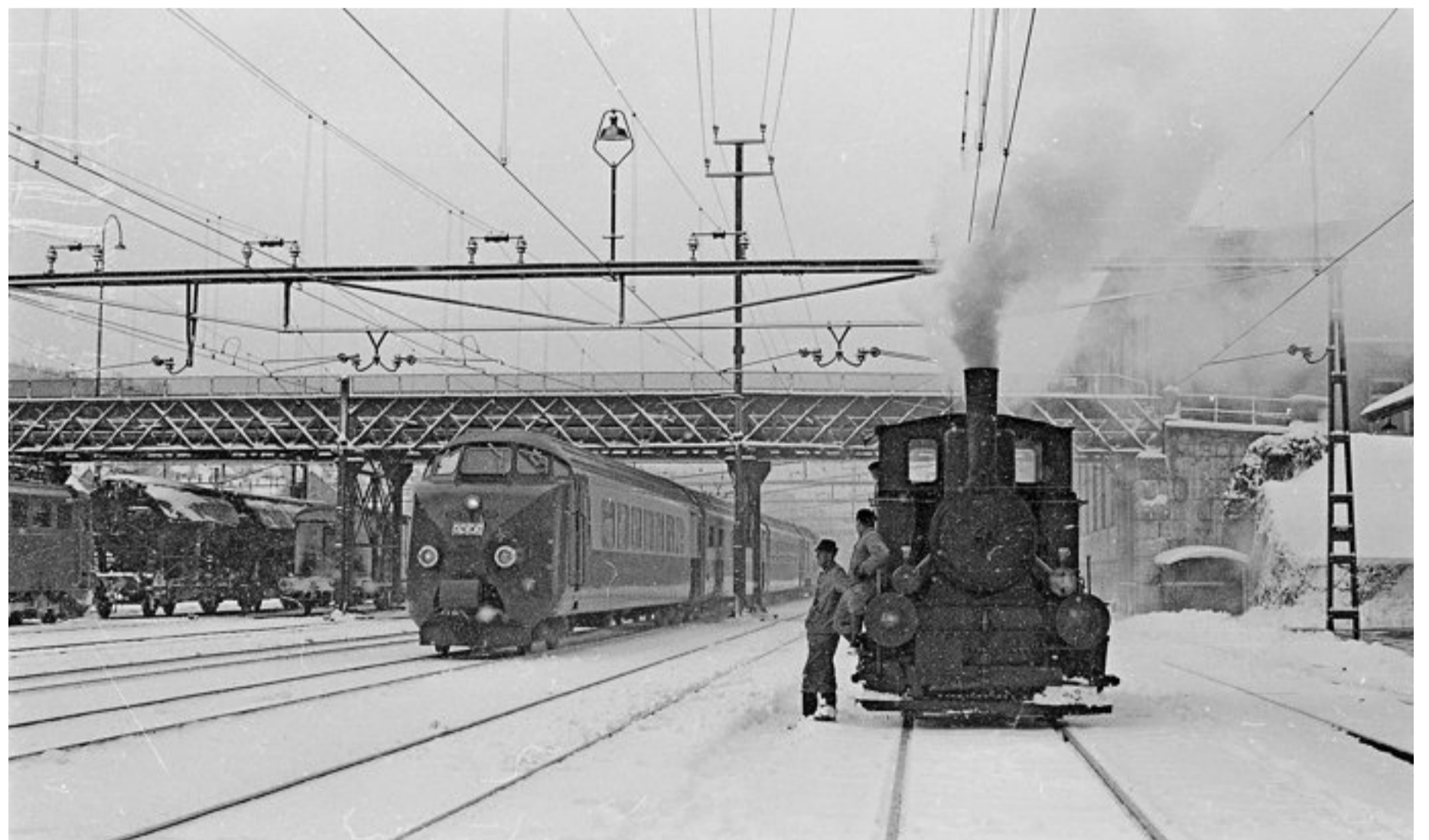
Die Einfahrt des TEE Bavaria unter der alten Wylandbrücke hindurch in Richtung Bahnhof, erregt augenscheinlich die Aufmerksamkeit der Bahnarbeiter.
