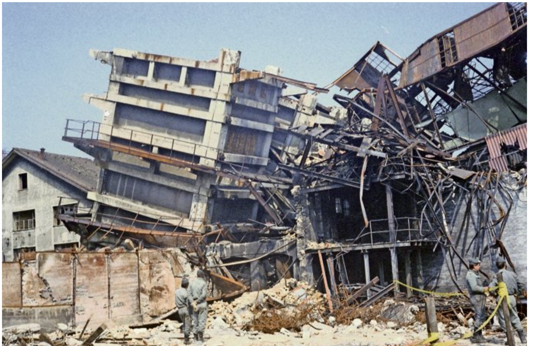
Das Gaswerk im Schöntal wurde 1986 nicht mehr benötigt, weil die Stadt schon 1974 die Gasproduktion aufgegeben und auf das günstigere Erdgas umgestellt hatte.
